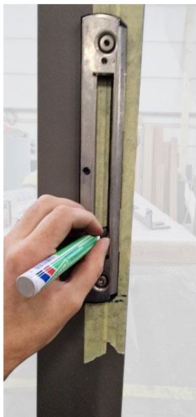
9. Als beide montagepunten klaar zijn plaats de slotvanger terug zonder vast te zetten, teken de slotgleuf af.
