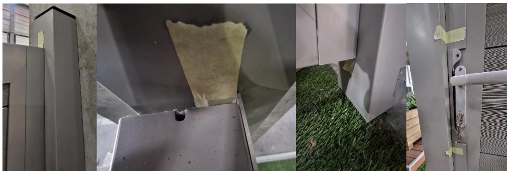
9. Plaats de L-profielen tot tegen de poortvleugel en maak deze tijdelijk vast met schilderstape.
