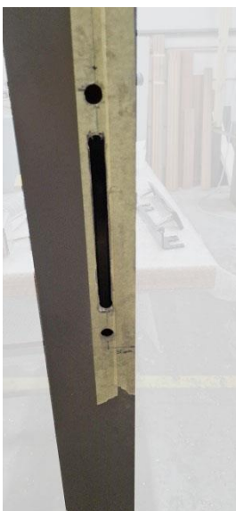
11. Zaag met een slijptol of multitool de gleuf uit.
