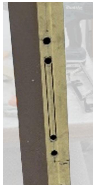
10. Verwijder de slotvanger en boor bovenaan en onderaan de slotgleuf een gat Ø14,2mm
