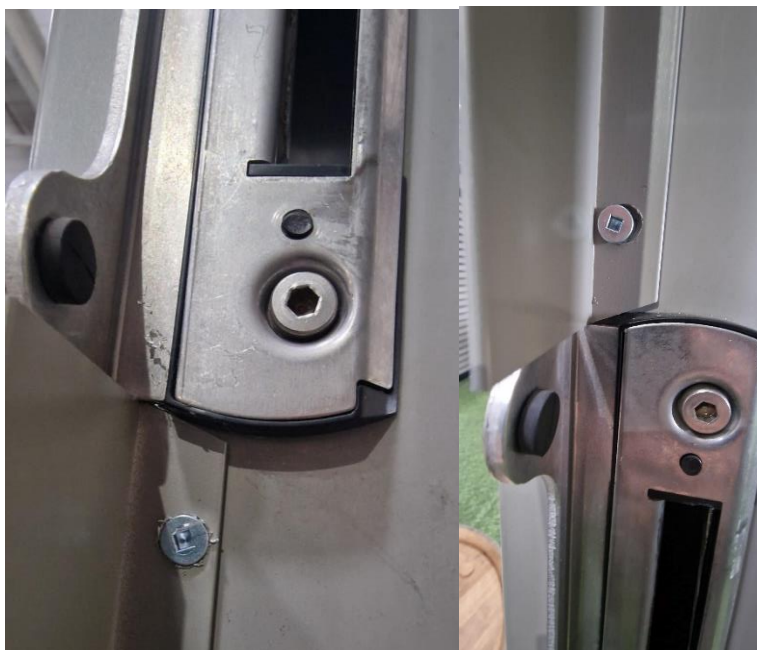
10. Schroef de L-profielen vast van zelftappers, bij zwarte profielen zijn zwarte zelftappers mogelijk voor een propere afwerking.
